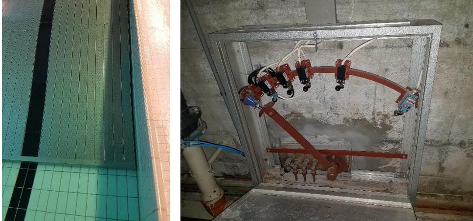
Abbildungen 22/23: Teilhubboden mit Schürze, Steuerung Hubbodenmit Druckluft
