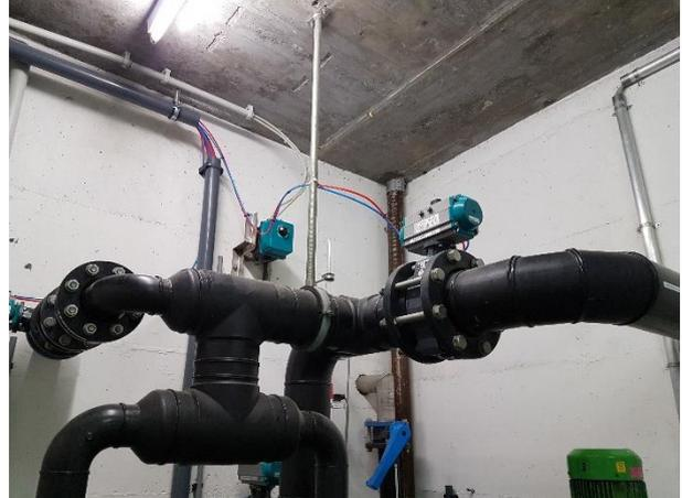
Abbildungen 8/9: Unterdruck- Anschwemmfilter (Kieselgur), Filterverrohrung mit Armaturen
