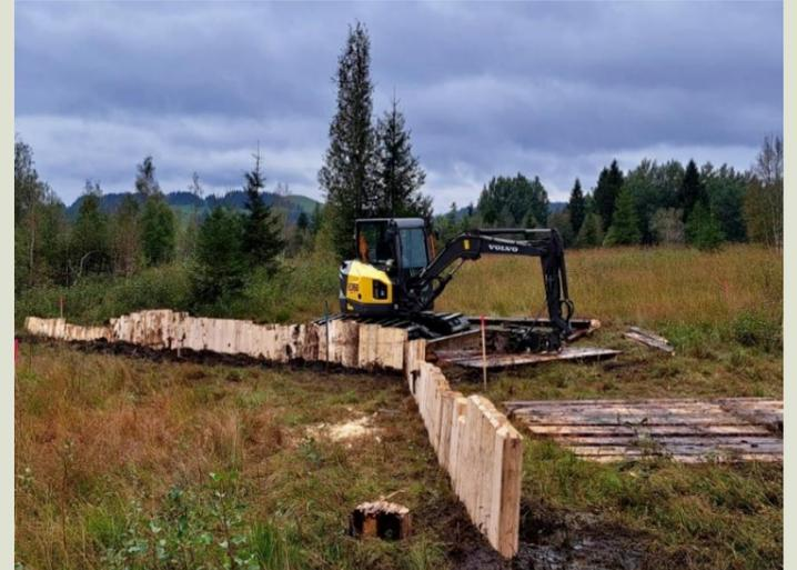
*Bau von Holzspundwänden zum verschliessen von Entwässerungsgräben*
